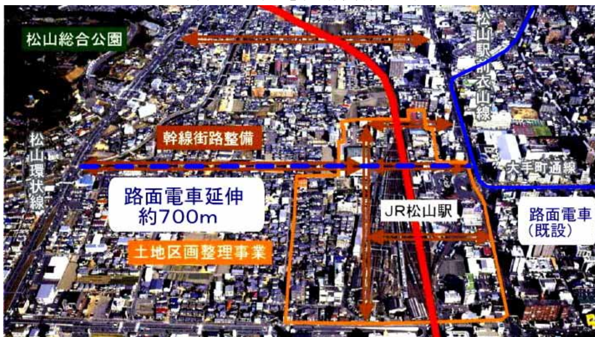
図表 2-14 路面電車延伸検討箇所の状況
