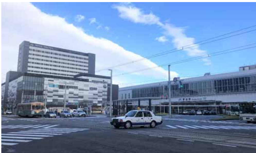
写真1-3 2022年3月開業の複合ビル（左）と富山駅南口駅前の様子
