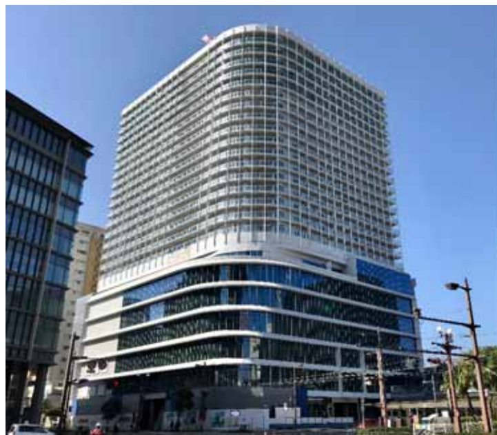
写真 1-25 鹿児島中央駅前から見た鹿児島中央タワー（建設中）
