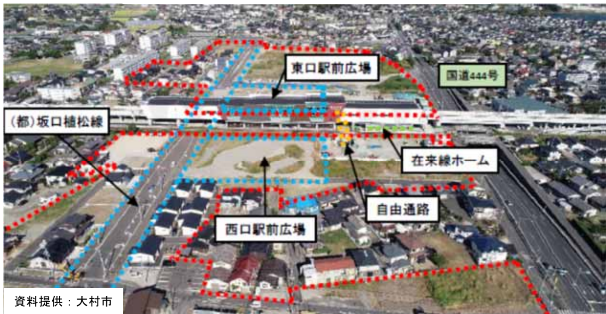
写真 1-22 新大村駅周辺整備事業の外観
