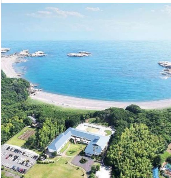
写真Ⅲ-6 クオリティソフト白浜本社外観
