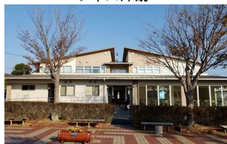
写真Ⅲ-4 白浜町第2ITビジネスオフィス外観
