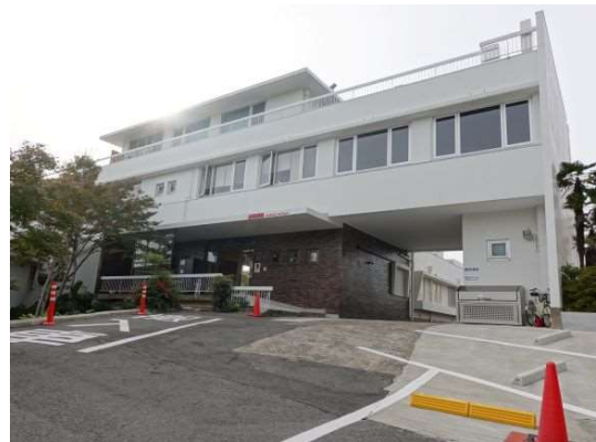
写真Ⅲ-5 ANCHOR 外観
